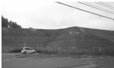
南三陸かさ上げ工事
