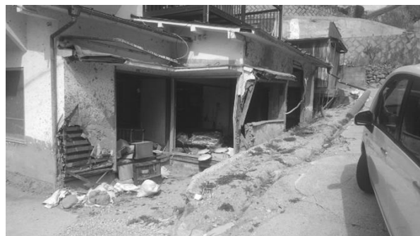
呉の被災現場
